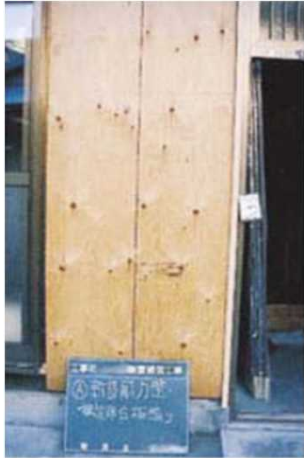
構造用合板による補強
