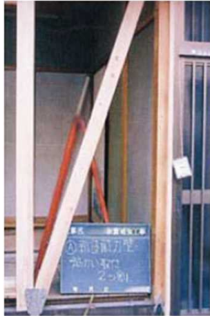
筋かいによる補強
