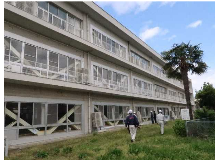
耐震改修を行った鉄筋コンクリート造建築物 (倒壊・崩壊の被害なし)
