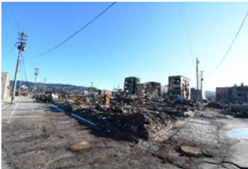
焼失した市街地の状況（輪島市）
