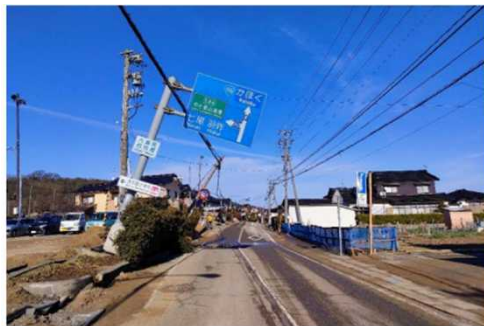
液状化した道路の状況（内灘町）
